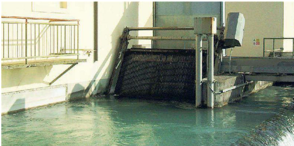
Uno degli sgrigliatori nei quali finiscono i caprioli e le lepri dopo essere caduti nei canali a Rive D'Arcano
