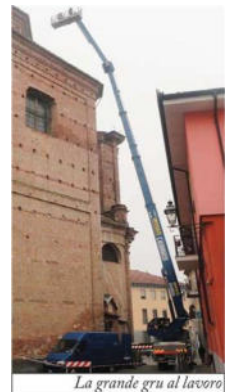
La grande gru al lavoro
