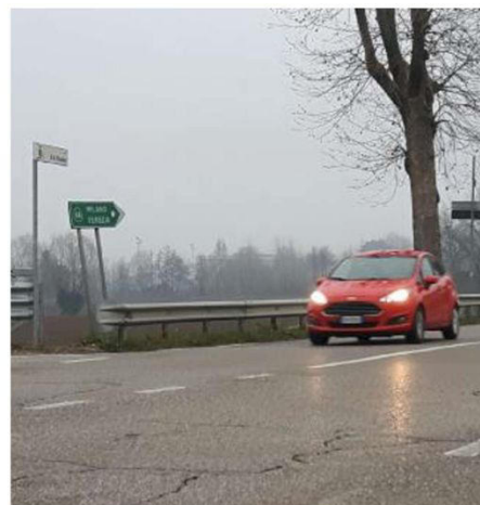
Il tratto della Sp 550 all'altezza del ponte sul Fiumicino Brendola. M.G.
