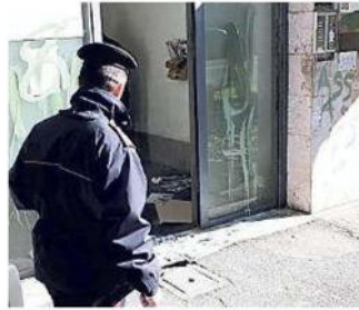
Il sopralluogo dei carabinieri
