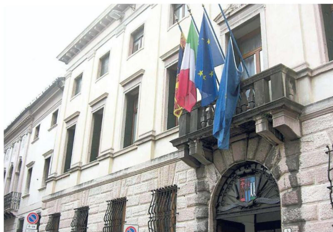
Palazzo Piloni, la sede della Provincia
